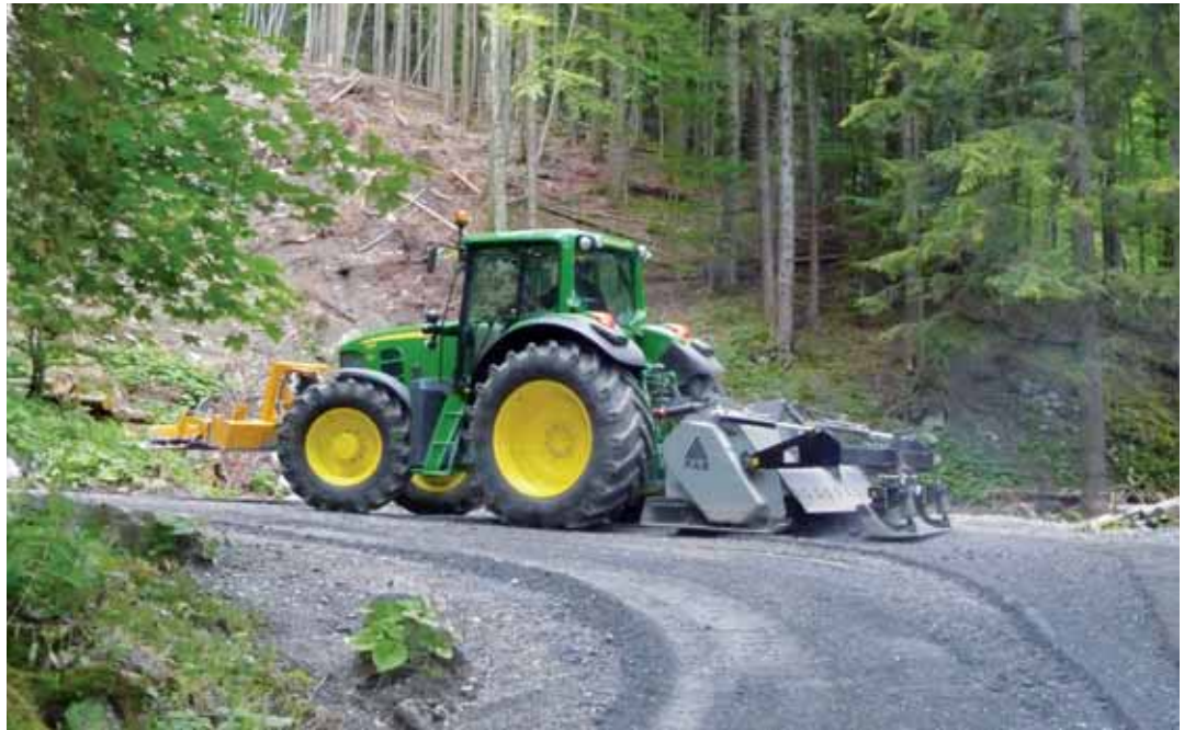
Sanierung der Naturstrasse mittels Traktor mit Brecher und Vibroplatte (vorne).
