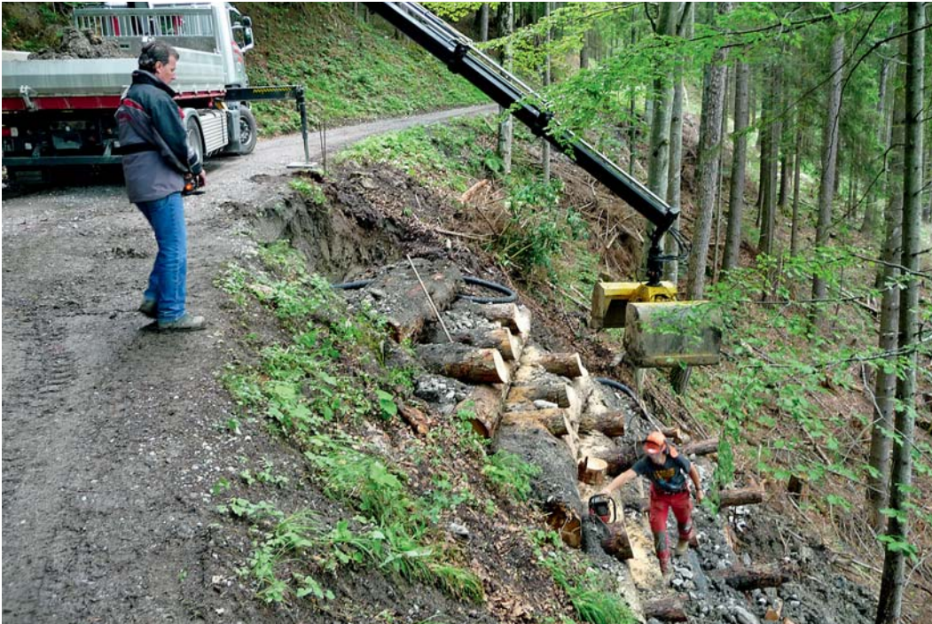
Um die Gafadurastrasse zu sichern, wurde der Erdrutsch mit einem Holzkasten verbaut.
