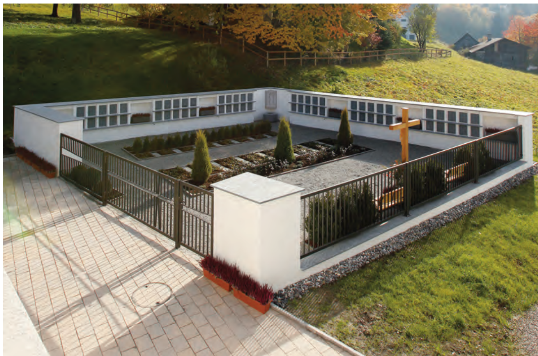
Rund ein halbes Jahr dauerten die Bauarbeiten für die letzte Ruhestätte.
