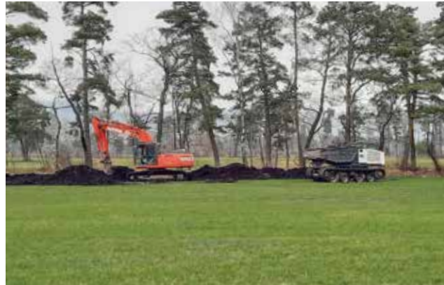
Rekultivierungsarbeiten im Plankner Äscher.
