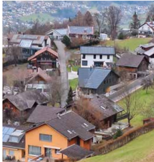
Die Dachflächen mit Photovoltaikanlagen nehmen zu.
