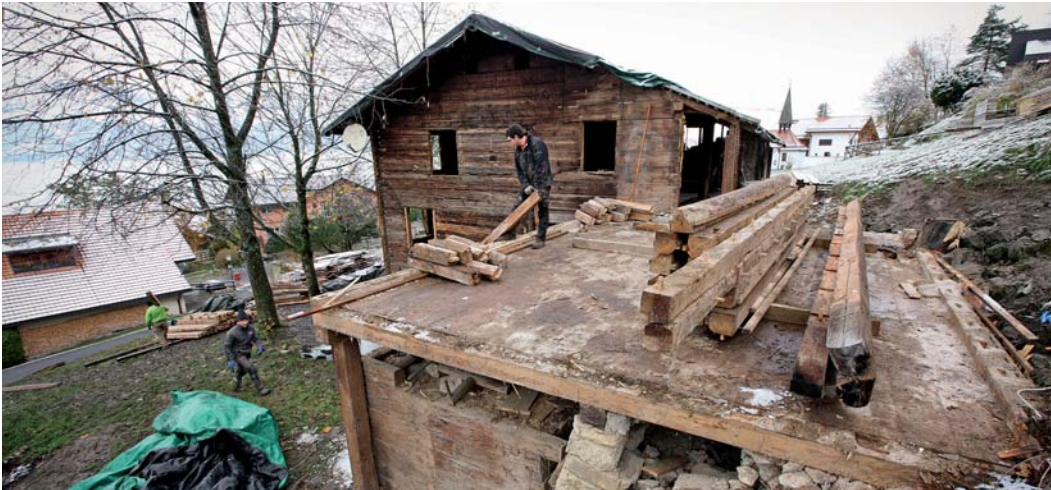
Die Abbrucharbeiten sind in vollem Gange.
