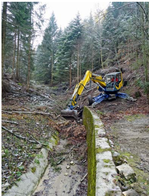
Räumung des Bachbettes von umgestürzten Bäumen.
