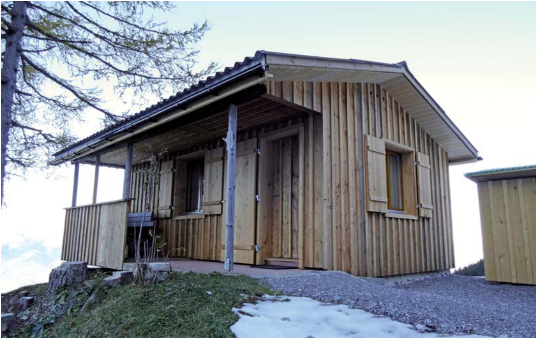
Die sanierte Jagdhütte auf Gafadura.
