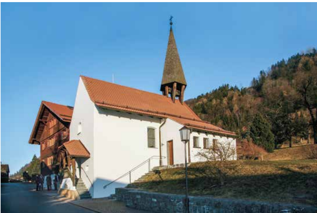
Kapelle St. Josef nach der Sanierung 2007.
