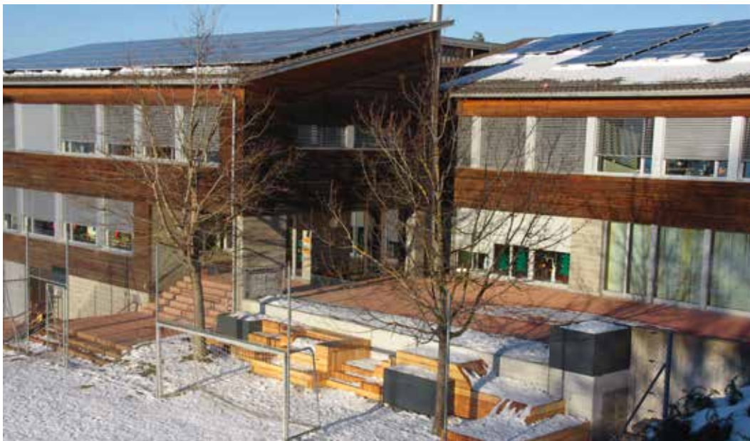
Grosszügige Pausenplatzfläche nach der Sanierung des Gemeindearchivs.
