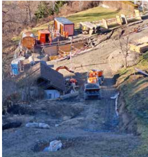
Bauarbeiten rund um das Regenbecken Kaserna.
