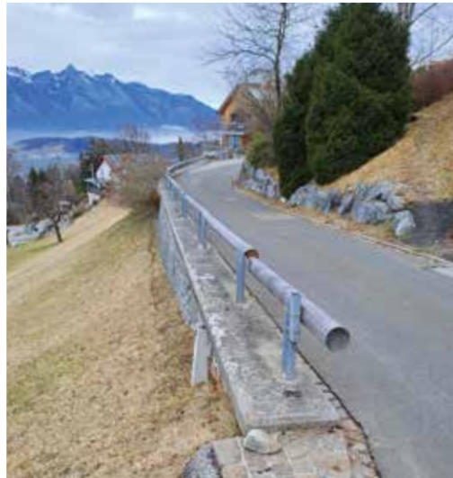
Anstelle von Holzleitplanken wird hier neu ein Staketengeländer aus Metall angebracht.
