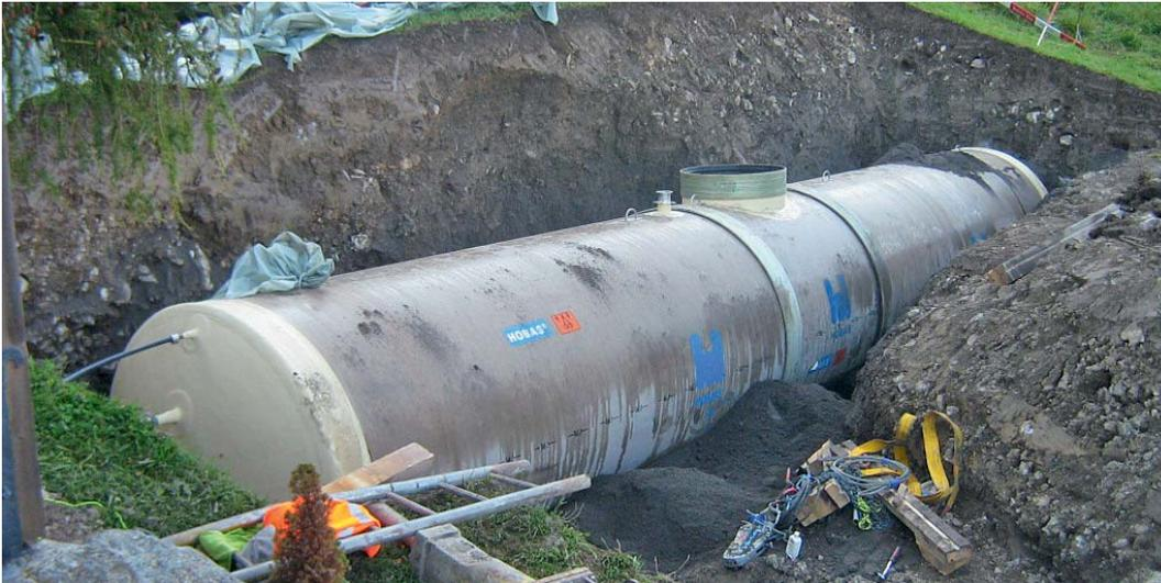
In diesem Kunststoff-tank stehen der Feuerwehr Planken im Ernstfall 40 000 Liter Wasser zur Verfügung.
