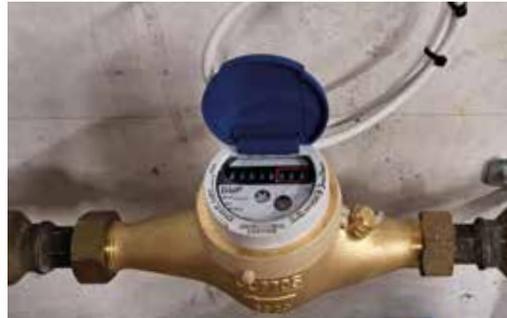
**Smart Meter Mehrstrahlwasserzähler.**
